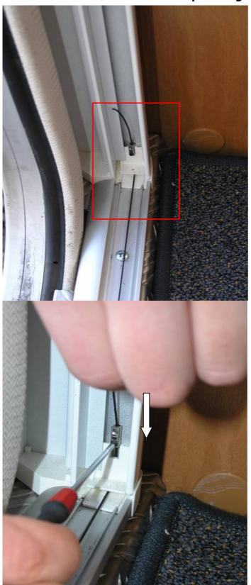
Einstellung der Schnurspannung an der abgebildeten Seite vornehmen (Seite ohne Insektenschutz)
